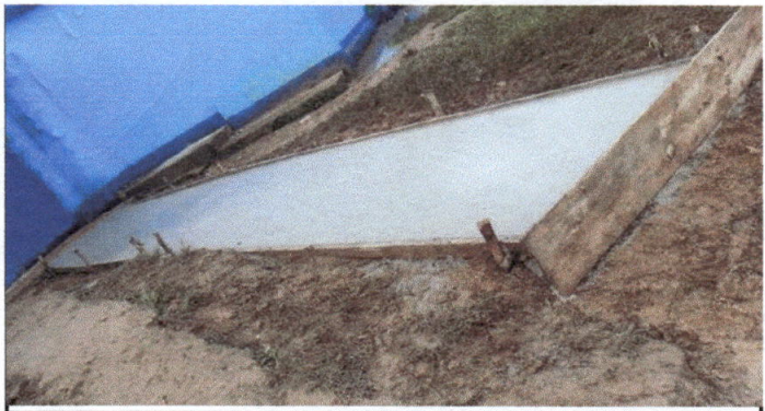
Foto 4: se observa que ya se fundio la primera fase del encaminamiento.
