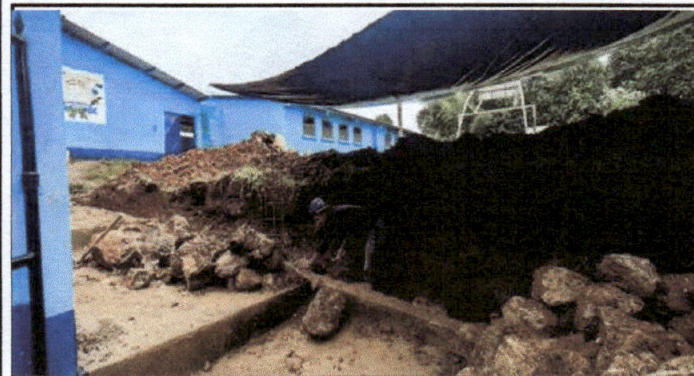
Foto 3: se observa que estan desarmando el anterior muro para repararlo.
