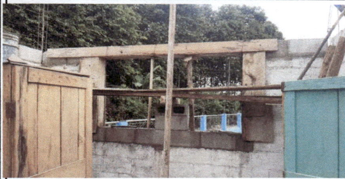
Foto 1: se observa como las instalaciones ya fue destechado, se esta levantando los muros y agrandando las ventanas.
